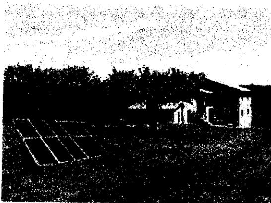
Figura 1: Esempio di un impianto a pannelli fisso a terra.
